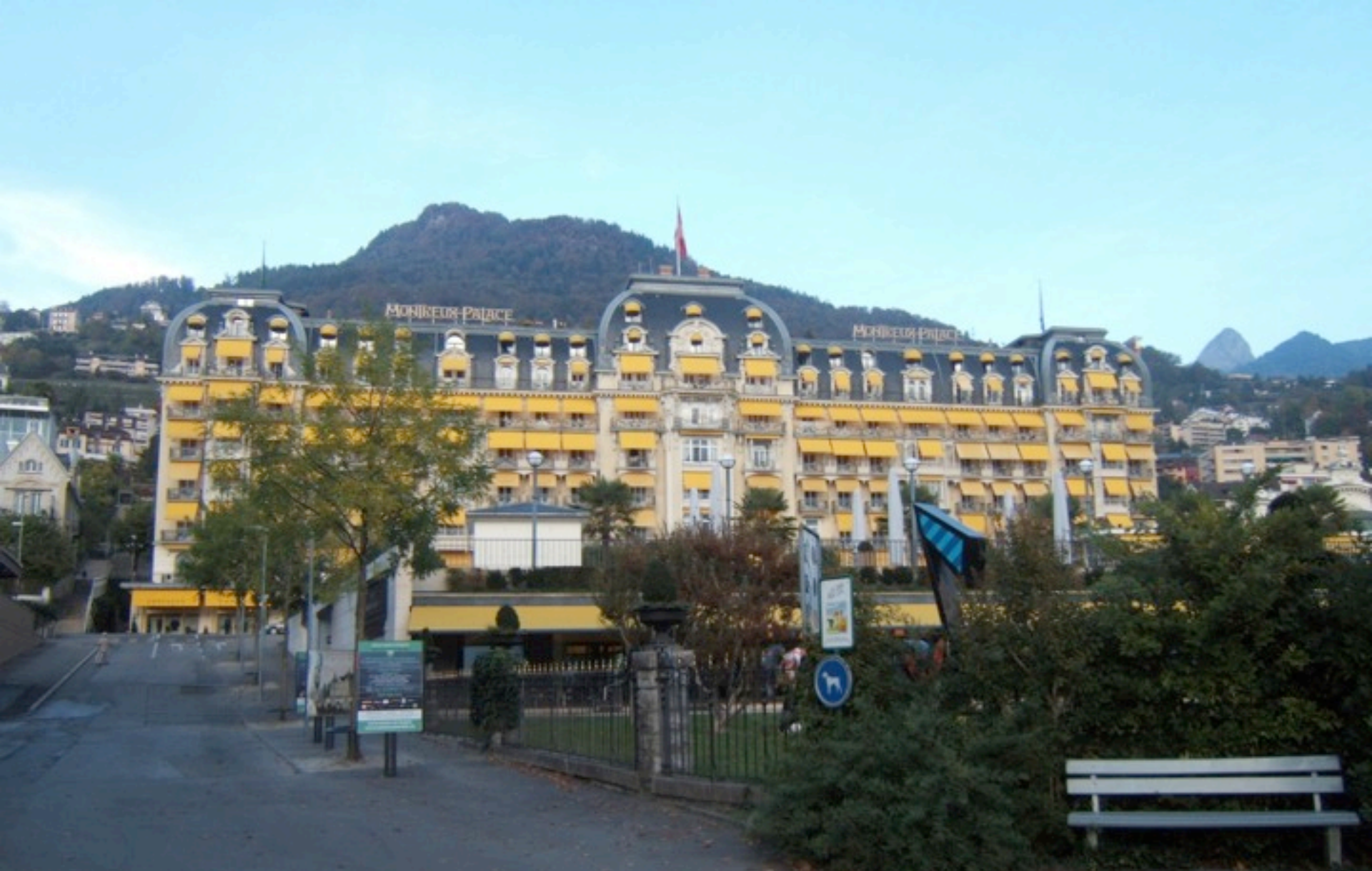
Restaurierung der Stuckmarmorsäulen Im Fairmont Hotel Le Montreux Palace in Montreux (Schweiz)
